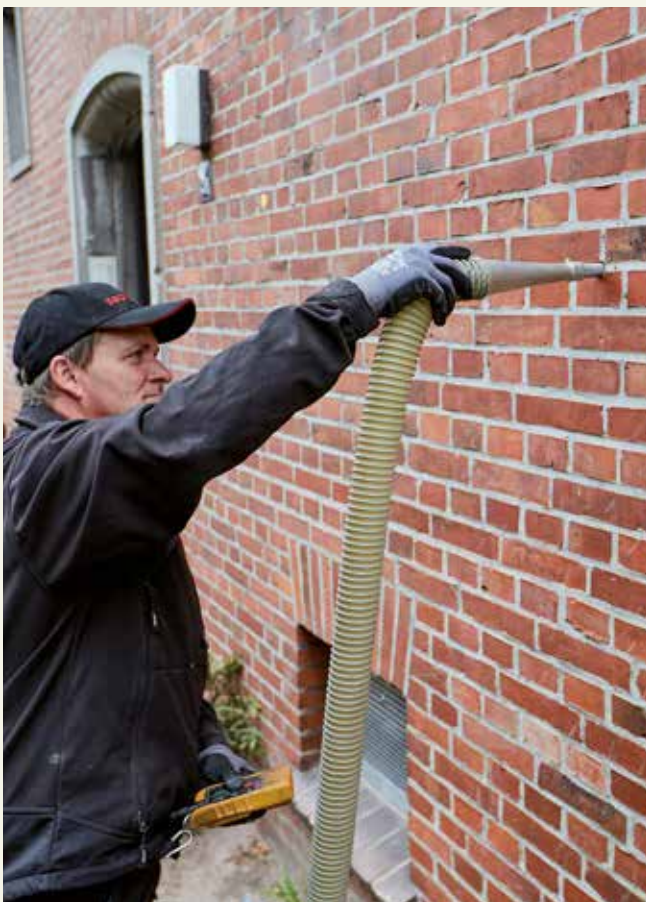
Die Hohlchicht wird mit einer oder mehreren Einblasmaschinen mit den passenden Düsen befüllt.
