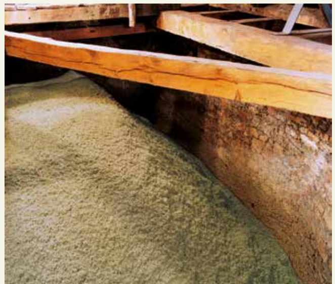
Abrutschsicher aufgebaute Dämmschicht mit Fillrock RG. Die Dämmschicht ist auch bei gewölbten Untergründen lagestabil.
