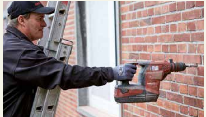
In gleichmäßigen Abständen werden Löcher in die T-Fugen gebohrt.
