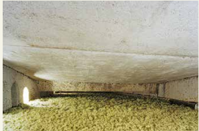
Belüftetes Flachdach mit Fillrock RG gedämmt
