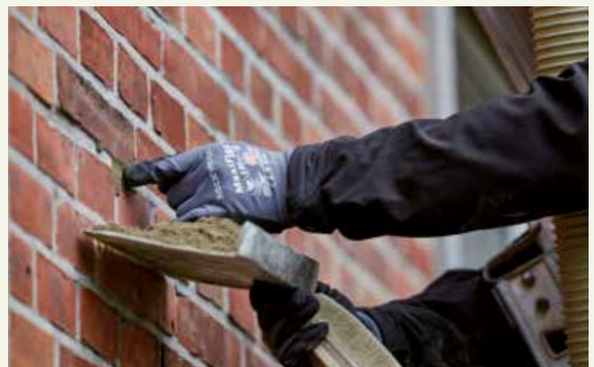
Anschließend werden die Bohrlöcher wieder so sauber verfügt,
