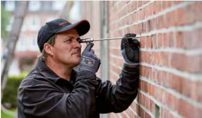
Die Hohlchicht wird an mehreren Stellen mittels eines Endoskops untersucht.
