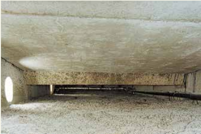
Belüftetes Flachdach vor dem Einbringen von Fillrock RG
