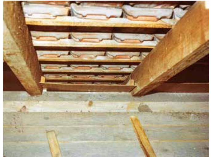
Die bislang ungedämmte Dachschräge wird für das Einblasdämmsystem vorbereitet. Mit ROCKWOOL Fillrock RG wurde sie (mit Hinterlüftung) schnell und sicher gedämmt (s. Foto unten).
