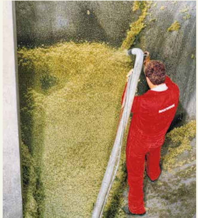
Gleichmäßiges Aufbringen der fugenlosen Dämmschicht. Anschließend werden die Steinwolle-Flocken mit Sprühkleber benetzt.
