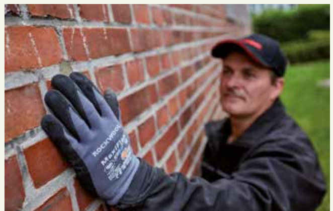
... dass man später nicht mehr erkennen kann, an welchen Stellen sich die Bohrlöcher befanden.
