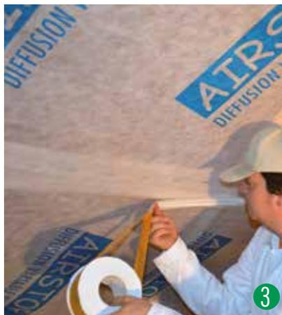
Ganz wichtig ist die luftdichte Verklebung und Abdichtung von Überlappungen, Anschlüssen und Durchdringungen. Siehe dazu die Broschüre „Luftdicht im Detail“.
