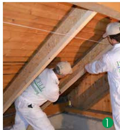
Je nach gewünschter Dämmstärke werden die Sparren an der Innenseite des Dachraumes verstärkt (aufgedoppelt). Für die Konstruktion sind hier zwei Varianten abgebildet (siehe Detailzeichnungen).
