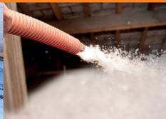
Knauf Insulation Supafil Loft Plus ist ein loser, von Natur aus nichtbrennbarer, mineralischer Dämmstoff, der ein wenig an Watte erinnert. Er wird über Schläuche direkt auf die Oberste Geschossdecke aufgeblasen.
